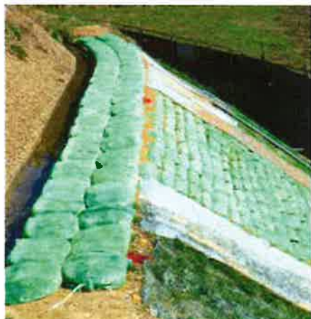
法面崩壊部分の埋戻し
