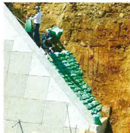
擁壁裏の土砂流出防止
