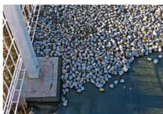
シート敷設完了
